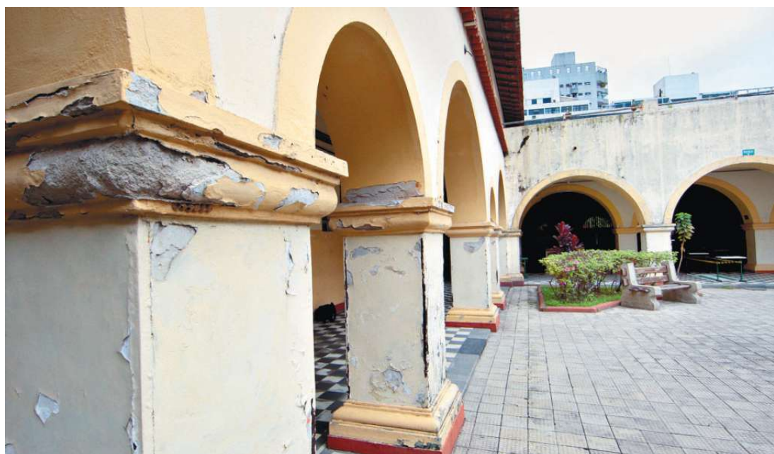
Descamação da pintura, feita para se chegar à cor original, identificou dez camadas de tinta em paredes
