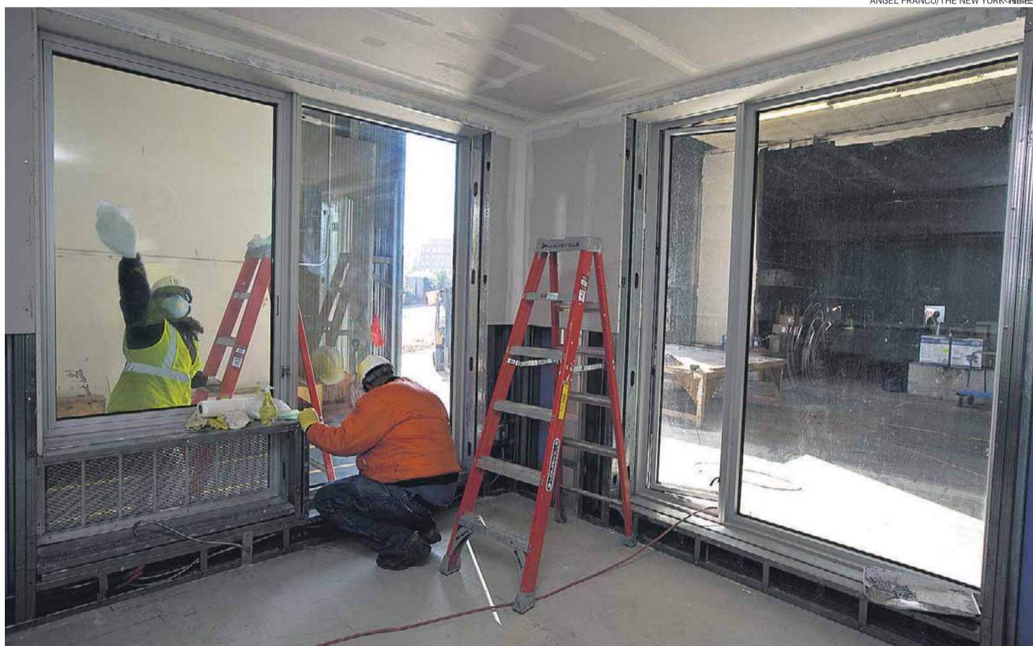
Montagem. Trabalhadores constroem a estrutura de um apartamento modular em um armazém no Navy Yard Brooklyn
