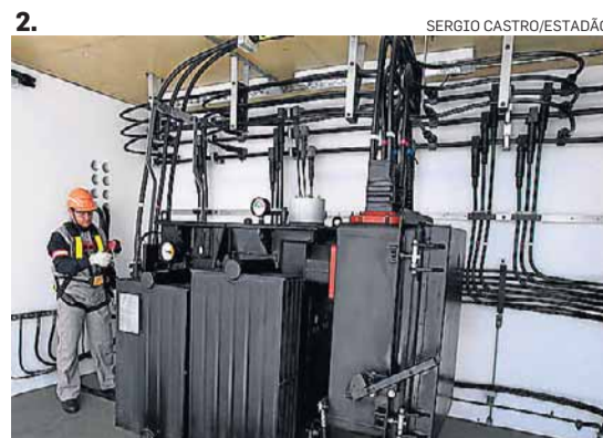
2. Em 2013 e 2014, foram enterrados 15 quilômetros de fiação no Município
