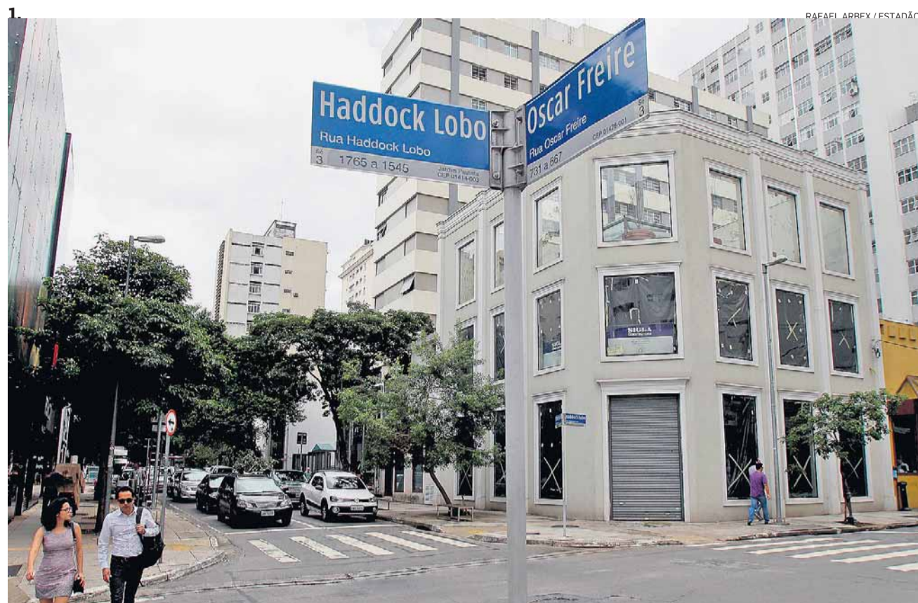
1. Na Rua Oscar Freire, a instalação subterrânea foi possível porque já integrava a proposta de revitalização
