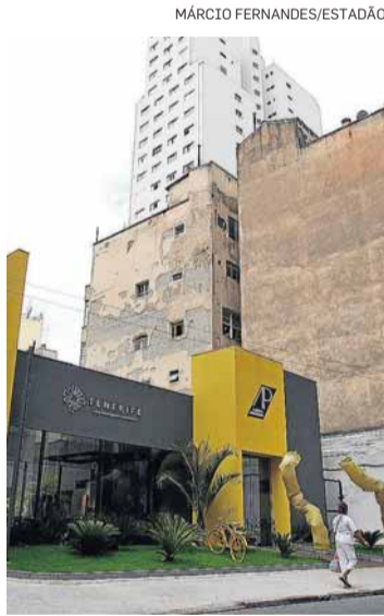
Novo. Prédio na Aurora terá 18 andares e 149 unidades
