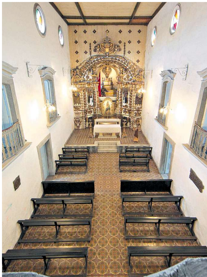
Vista geral da capela, que precisa passar por intervenções estruturais
