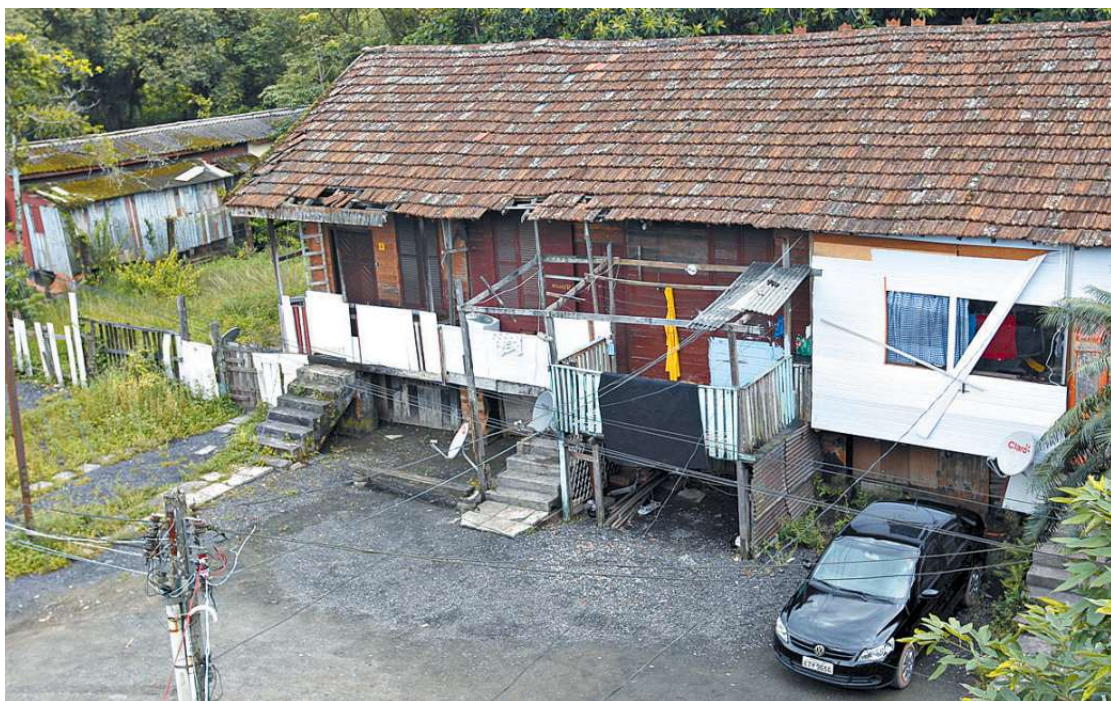
Seguindo a tradição, as casas eram erguidas sobre bases suspensas, para escapar da umidade do inverno
