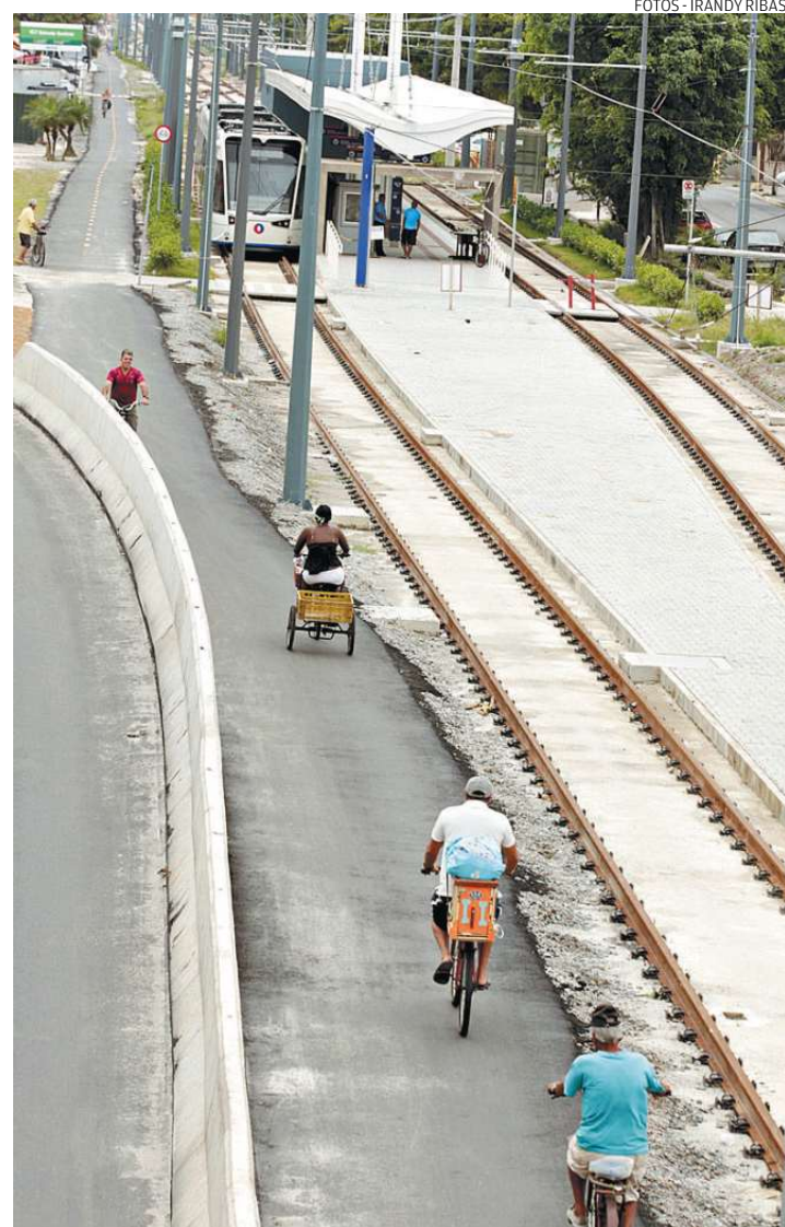
Outra novidade: a ciclovia também segue pela parte sob o viaduto
