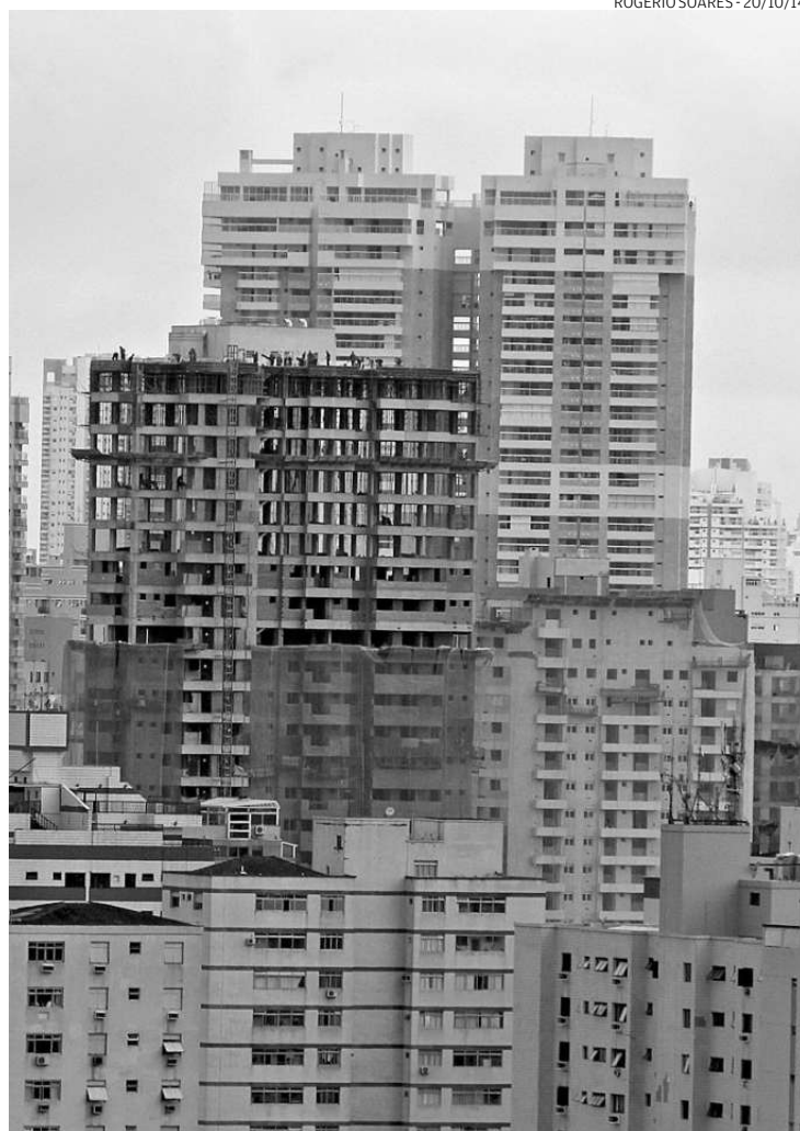
Comprador deve se informar sobre as saídas de energia ainda na obra
