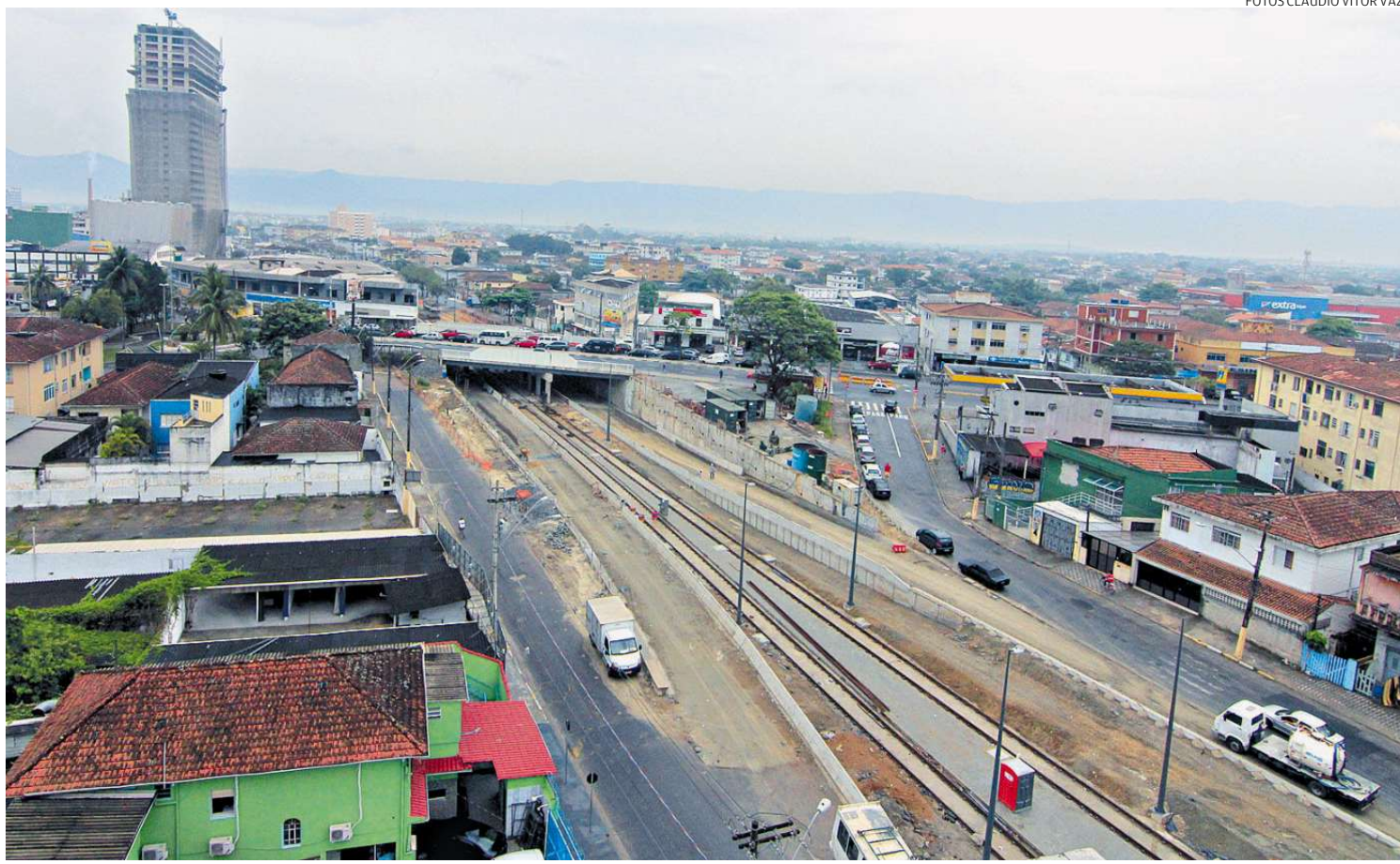
A expectativa da EMTU é que 30 mil passageiros utilizem diariamente o primeiro trecho, compreendido entre os terminais Barreiros e Porto
