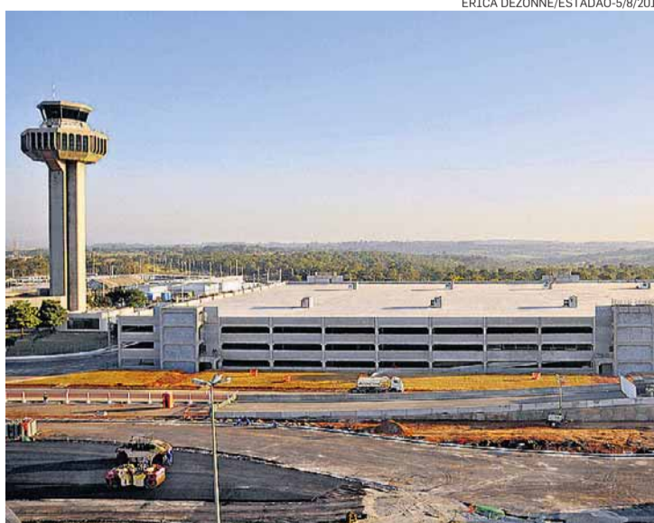
Obras. Dois operários morreram em acidente de trabalho
