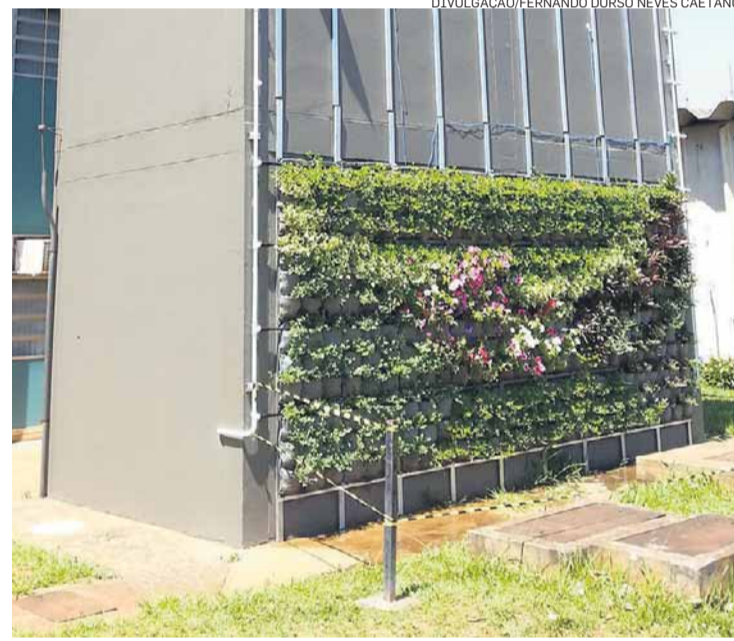
Na Unicamp. Temperatura interna caiu em até 6° Celsius
