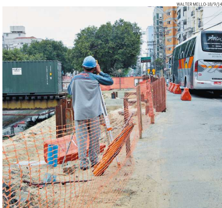
No Canal 1, pontilhão já está sendo ampliado para acomodar o trem
