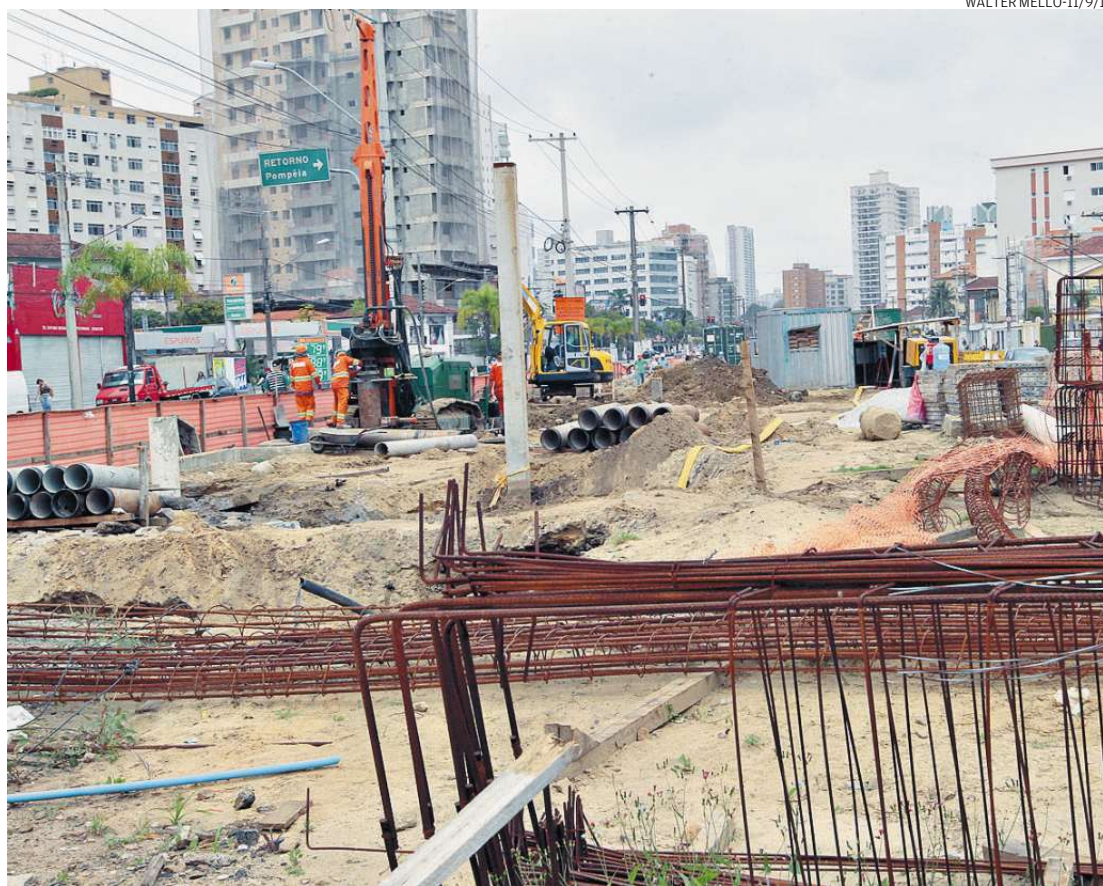
Obras começam a chegar à altura do Canal 2, o ponto polêmico. Nesse trecho, o VLT vai para o meio da via
