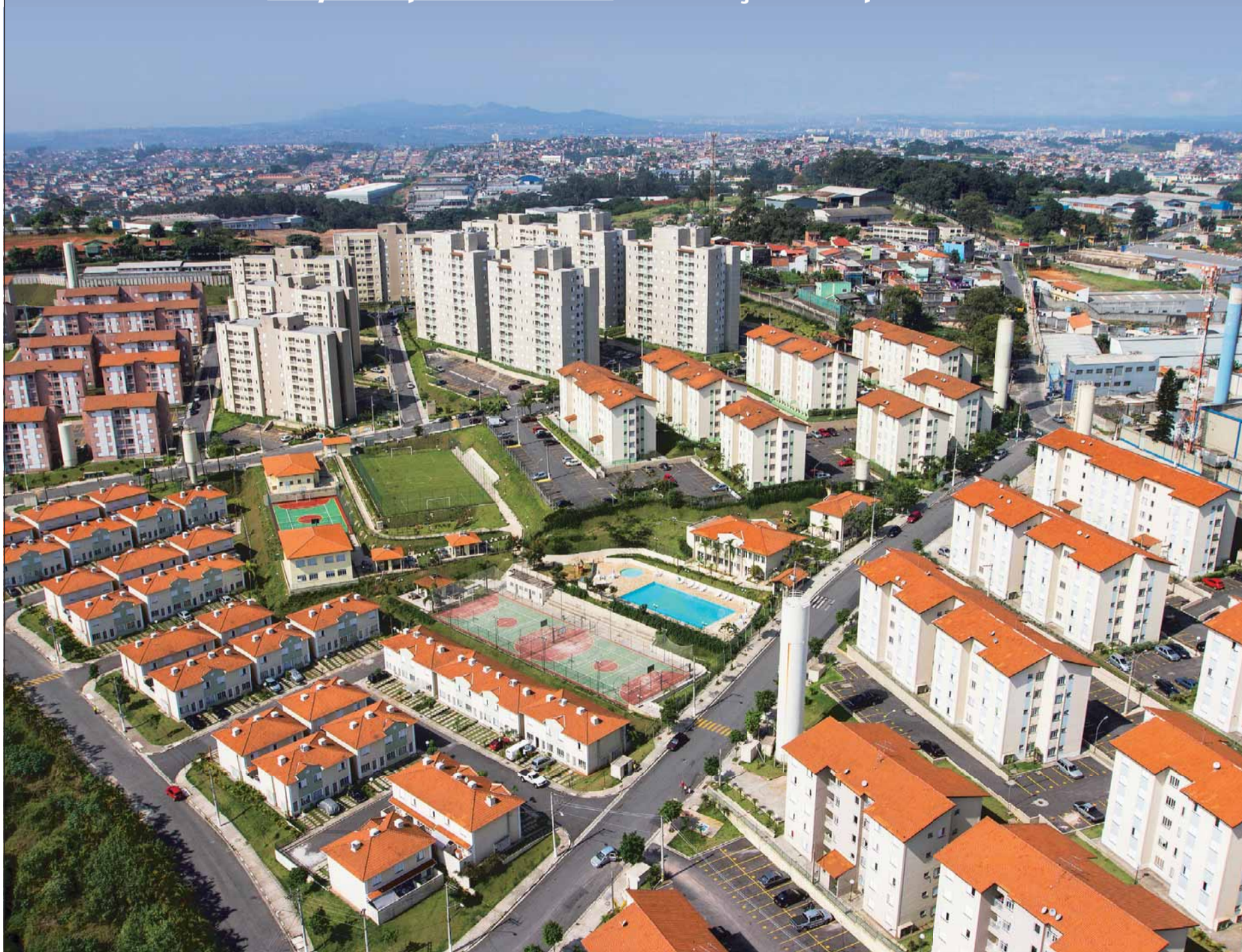
Foto aérea do empreendimento
