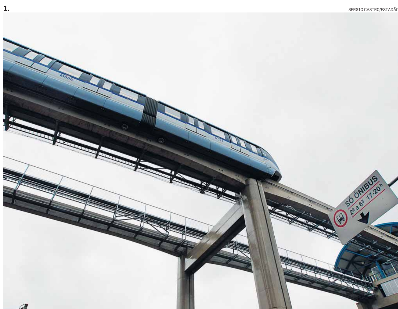
1. Monotrilho circula sustentado por vigas a 15 metros de altura de movimentada avenida na zona leste de São Paulo
