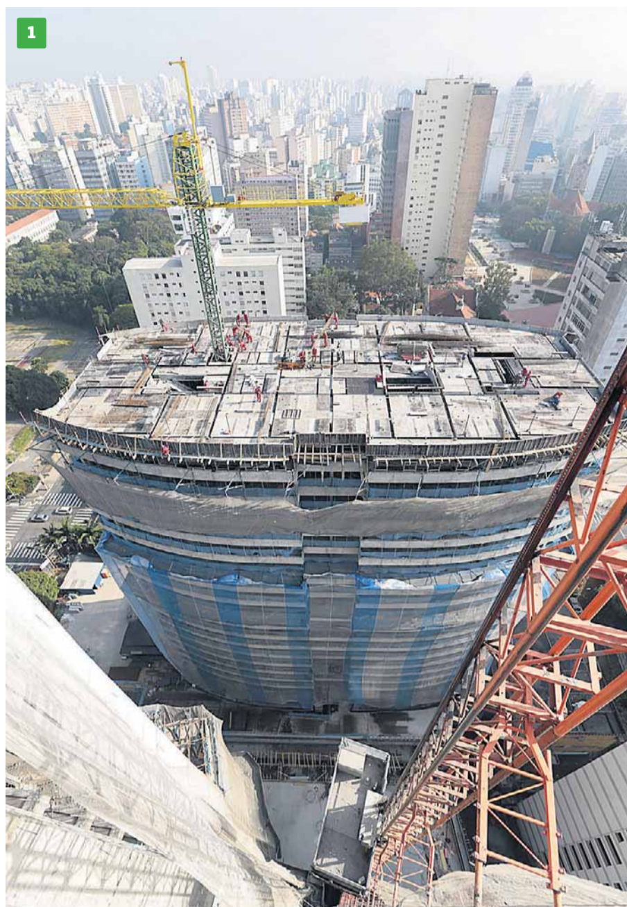
1. Prédios terão 27 e 31 andares e, por causa do pé-direito alto, equivalem a edifícios de 45 pavimentos 2. Atualmente, 450 operários trabalham na construção 3. Torres têm mais de 100 metros de altura 4. Homens trabalham 12 horas por dia
