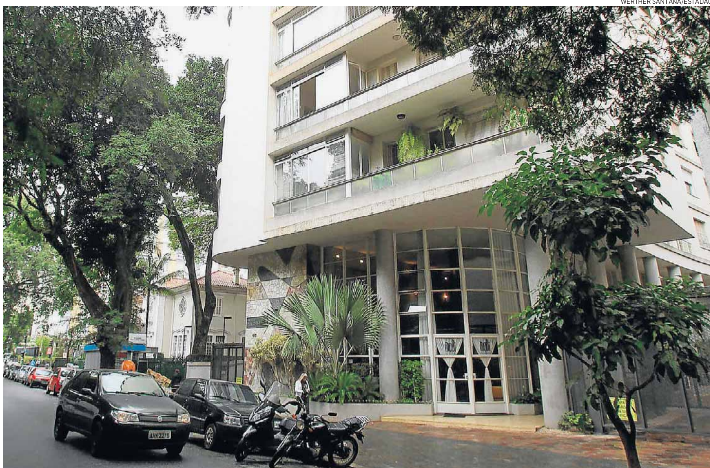
Integração. Prédio erguido nos anos de 1950, em estilo modernista, já teve cabeleireiro, padaria e salão de beleza
