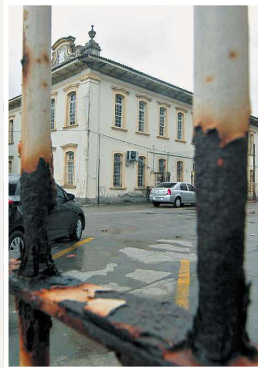
Ferrugem é visível na grade e no portão da entrada
