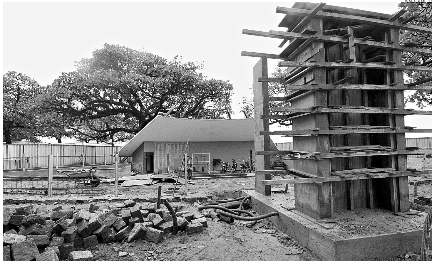
O espaço localizado na praia, na altura do Canal 3, está sendo totalmente reformado. O término dos serviços está previsto para novembro
