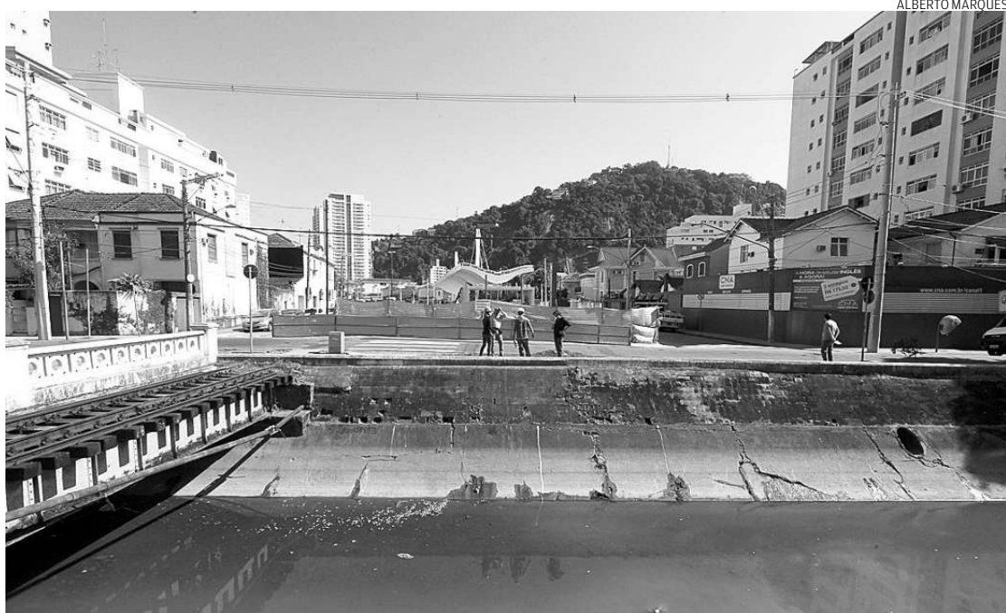
As pontes serão construídas na altura das ruas Alfredo Ximenes e Gaspar Ricardo durante quatro meses
