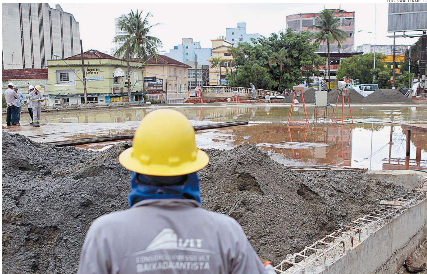
Prefeitura promete entrega na data e diz que o concreto do piso da Avenida Antônio Emmerich já foi aplicado. Secagem vai demorar três dias
