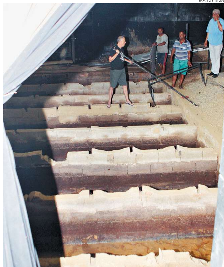
Ele foi fechado em 2009, em péssimas condições de conservação
