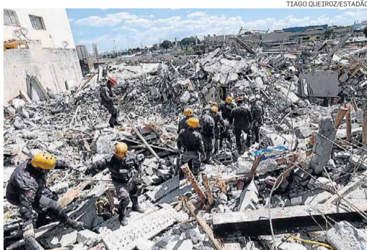
Trabalho. Remoção de entulho é feita manualmente
