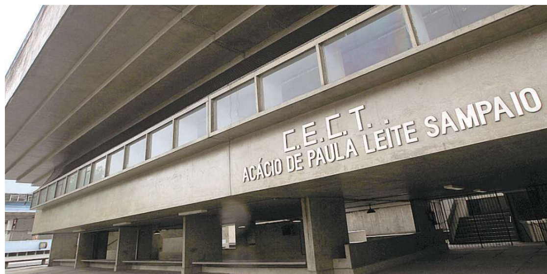
Edifício, construído há 44 anos, na Vila Nova, abrigará, em 2014, a terceira Escola Técnica de Santos (Etec)
